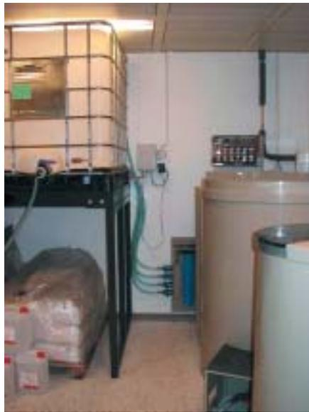
Produktionsanlagen mit Filtration und Verteilung für Konzentrate in Verbindung mit hochgestellten Lagertanks zur Schwerekräftversorgung zentraler Leitungen
